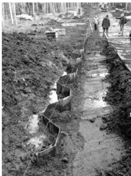
... impose un chantier conséquent
